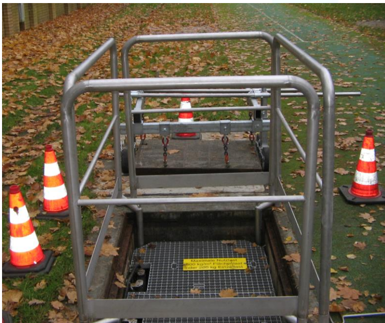
Abbildung: Gitterrostabdeckung mit Steckgeländer und versenkbare Steckhülsen (nach Regelblatt BWB; 2013)
